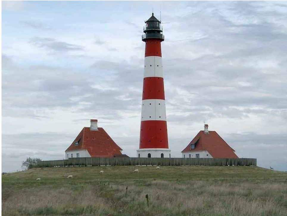
Leuchtturm Westerheversand (Blickrichtung nach Südosten)
